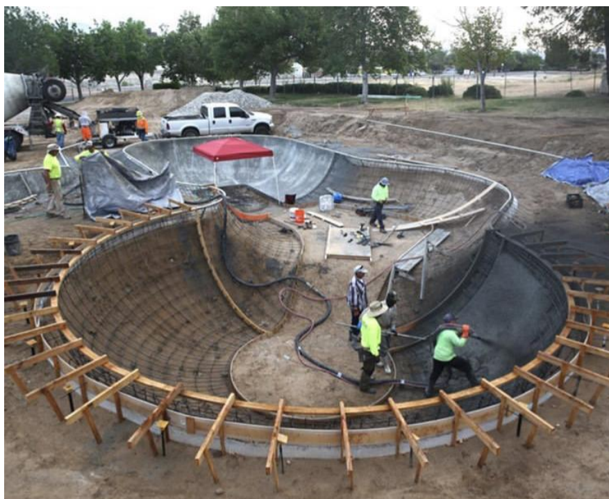
Imagem 07 – Exemplo de bowl similar, locação, marcação e concretagem. Fonte: Google
