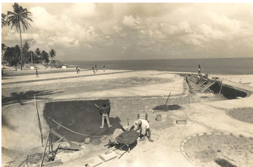
Imagem 02 – Construção do bowl da av. Beira Mar. Fonte: Blog Bisão
